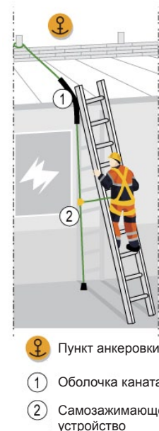
Рис. 3. Безопасный вход на крышу
